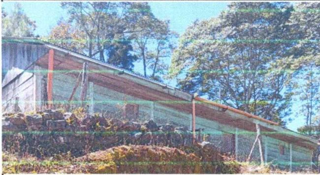
FOTO 1 SUSTITUCIÓN DE ENTECHADO DE LAMINA POR QUE LAS QUE TIENEN ESTAN EN MUY MAL ESTADO
