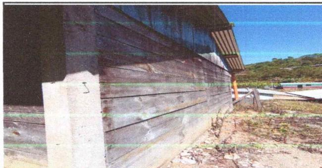
FOTO 5: SUSTITUCION DE VIGAS POR COSTANERAS Y REPELLE DE COLUMNAS
